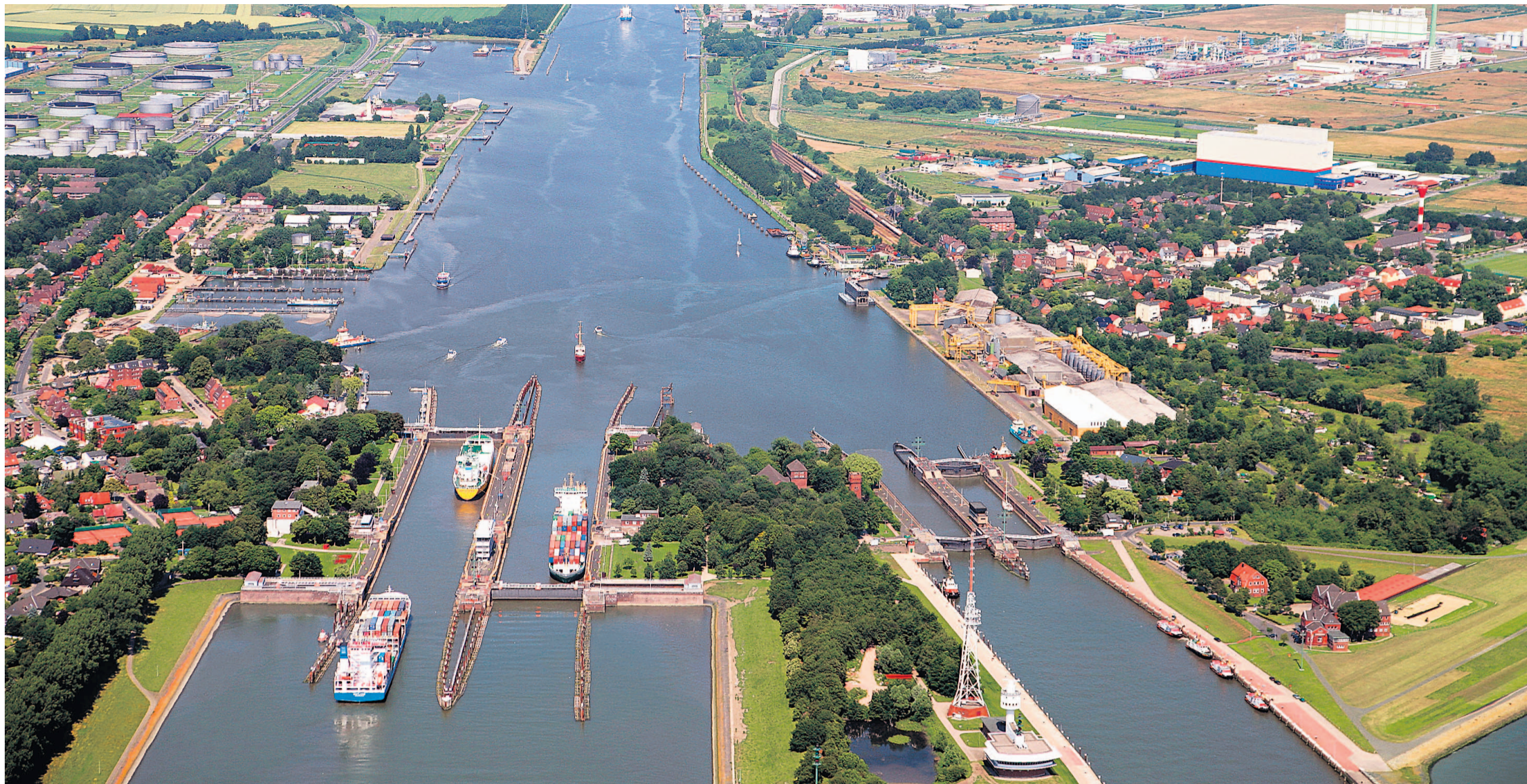
Die Schleuse des Nordostseekanals in Brunsbüttel soll erweitert werden. Der Bundestag stellte dafür insgesamt 300 Millionen Euro zur Verfügung.
