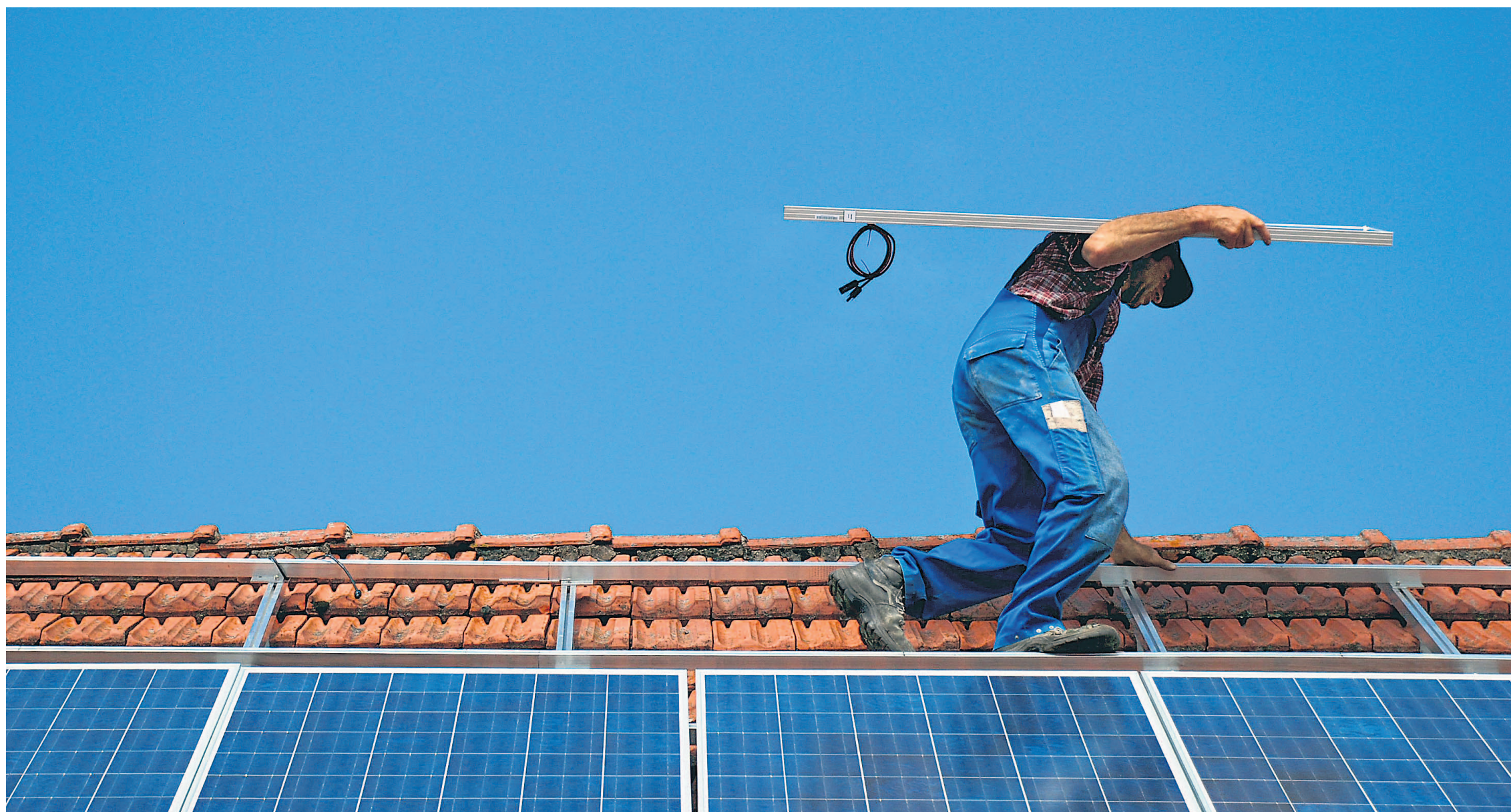
Rekordzubau von Photovoltaikanlagen: Nach den neuesten Zahlen der Bundesnetzagentur wurden 2011 insgesamt 238.000 Anlagen mit einer Leistung von 7.481 Megawatt in Deutschland installiert.
