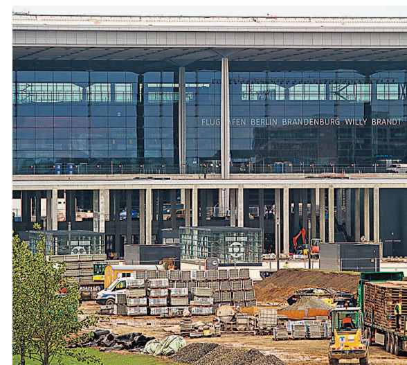
Die Bauarbeiten am neuen Flughafen gehen weiter.
