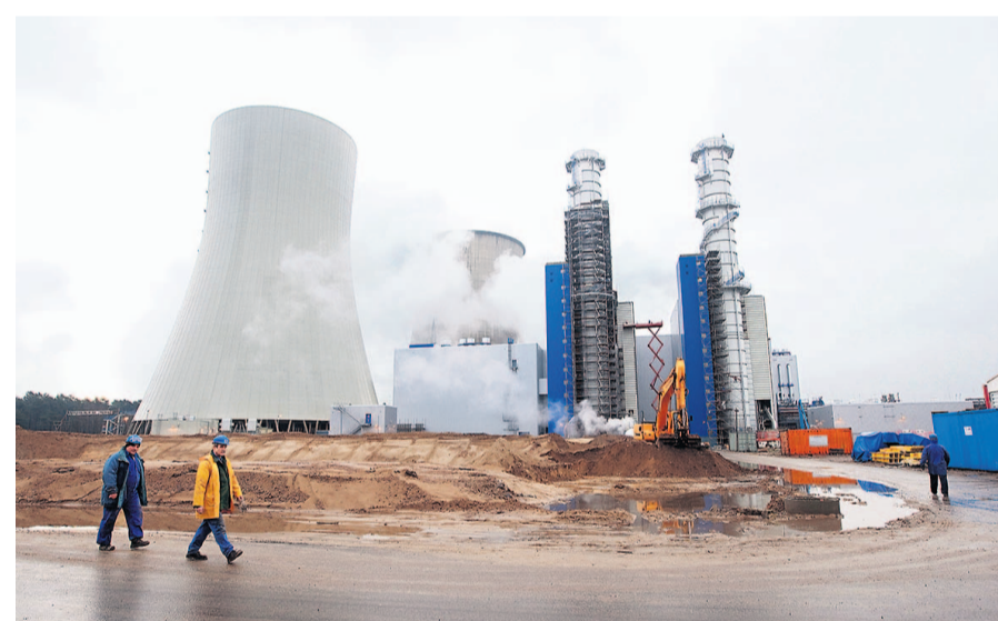
Gaskraftwerke wie hier in Lingen gelten jetzt als systemrelevant.
