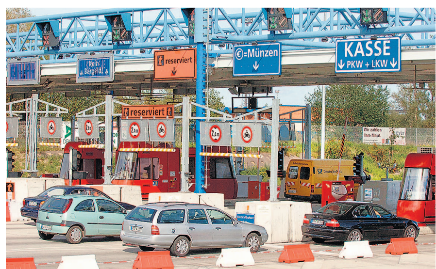
Der Warnowtunnel wurde als ÖPP-Projekt gebaut. Die Nutzer müssen zahlen.
