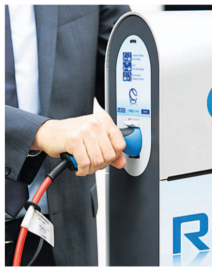
Ladestation für Elektro-Autos
