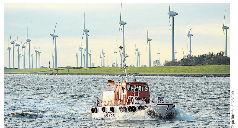
Windparkanlage in Norddeutschland.
