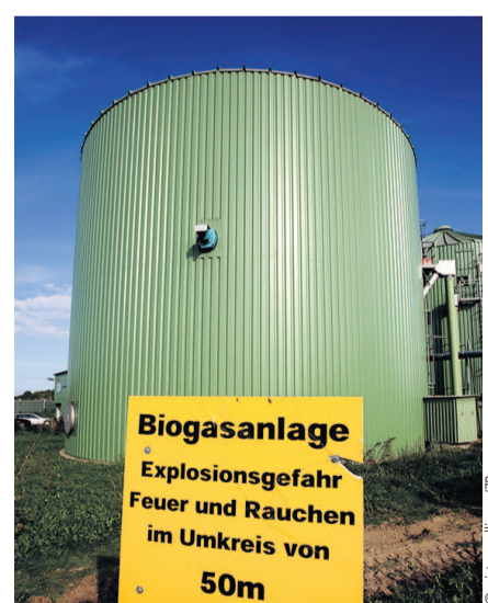
Biogasanlage in Krempin
