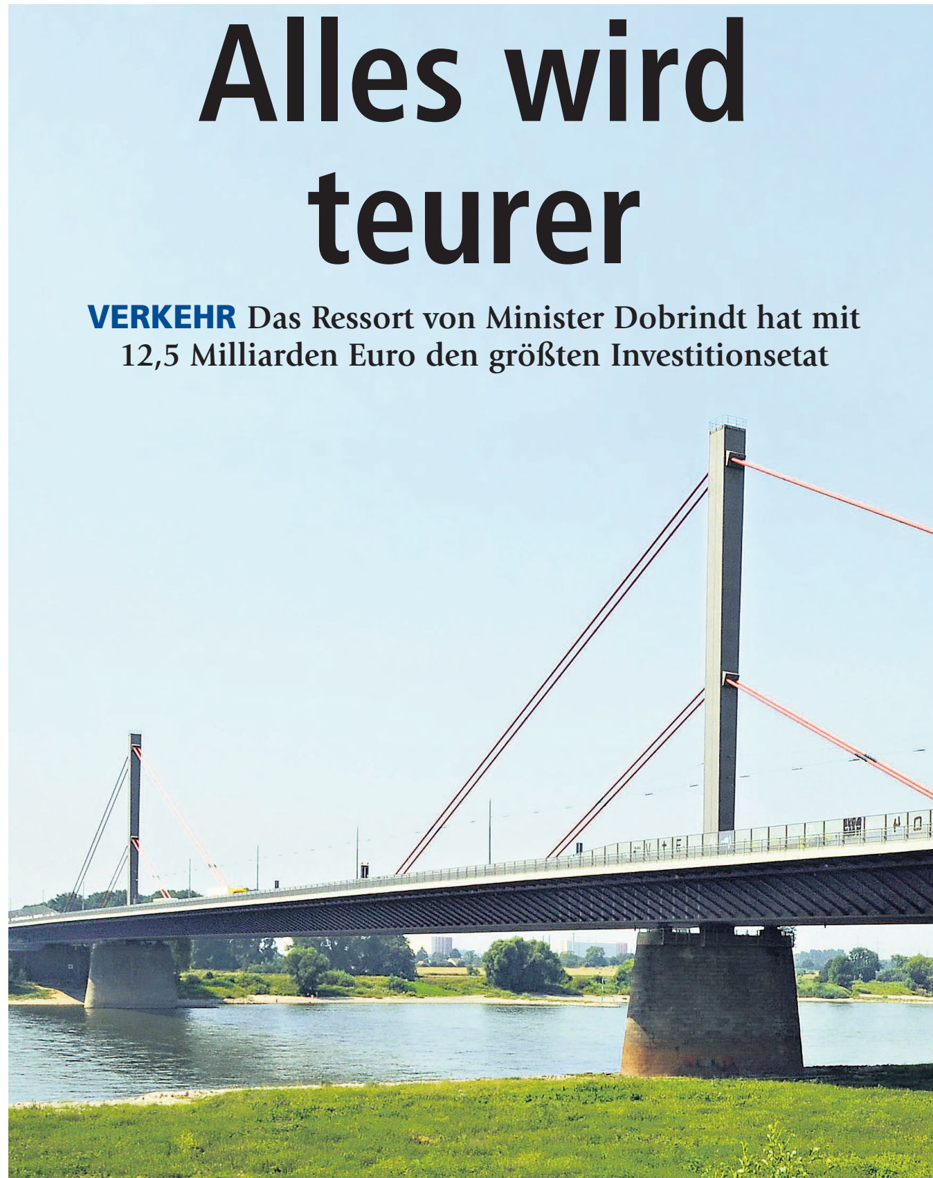
Mit bloßem Auge ist nichts zu erkennen. Trotzdem muss die Leverkusener Autobahnbrücke abgerissen werden.
