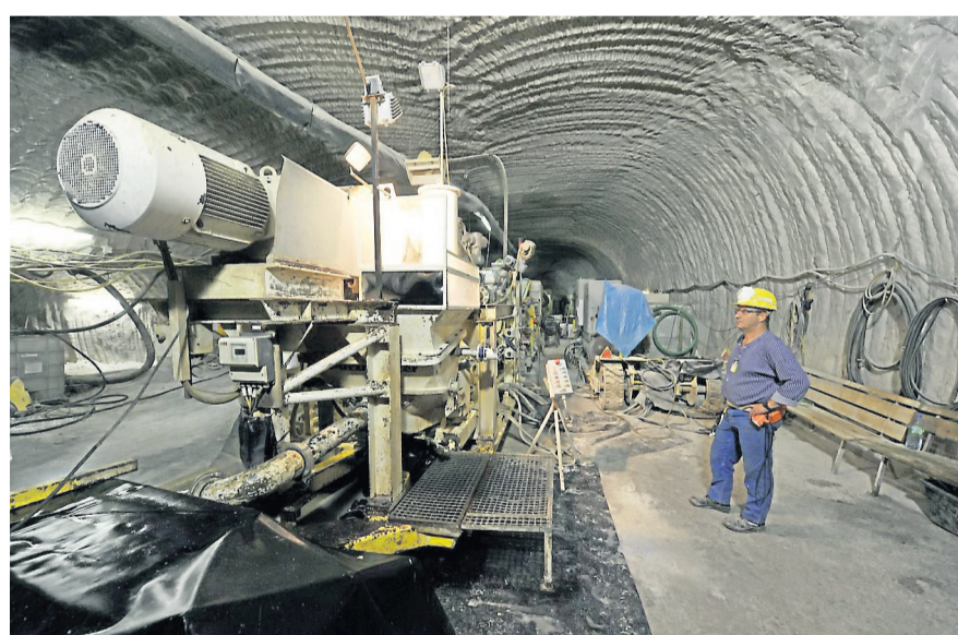
Betonierungsarbeiten in der Asse
