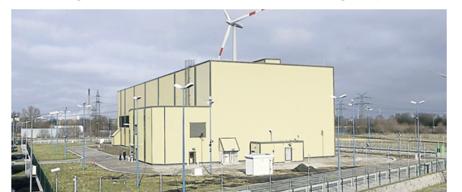
Das 2006 errichtete Zwischenlager des Atomkraftwerkes Brunsbüttel verlor im Januar wegen Sicherheitsbedenken seine Betriebsgenehmigung.
