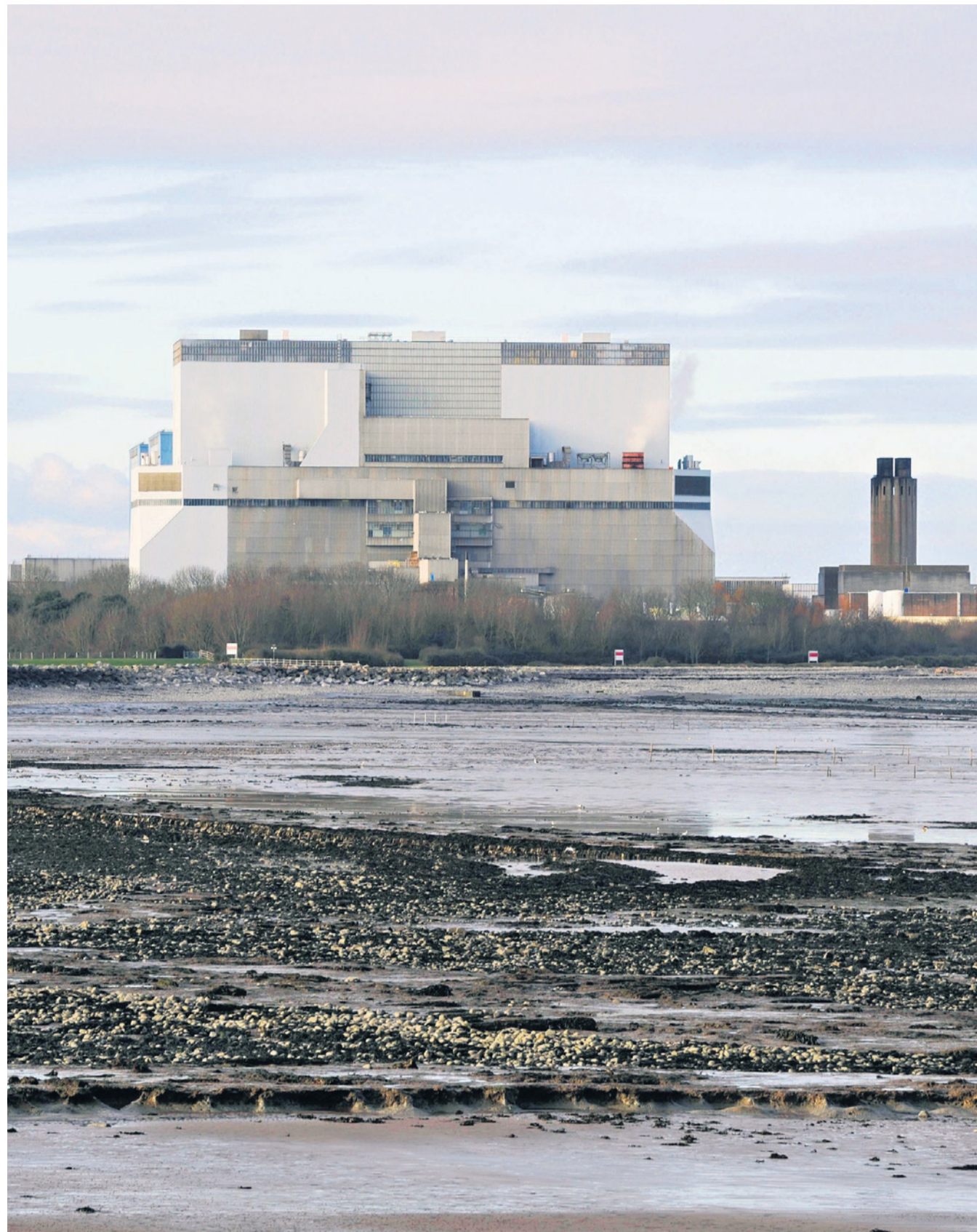
Mit britischer Unterstützung gebaut: Das neue Atomkraftwerk im englischen Hinkley Point
