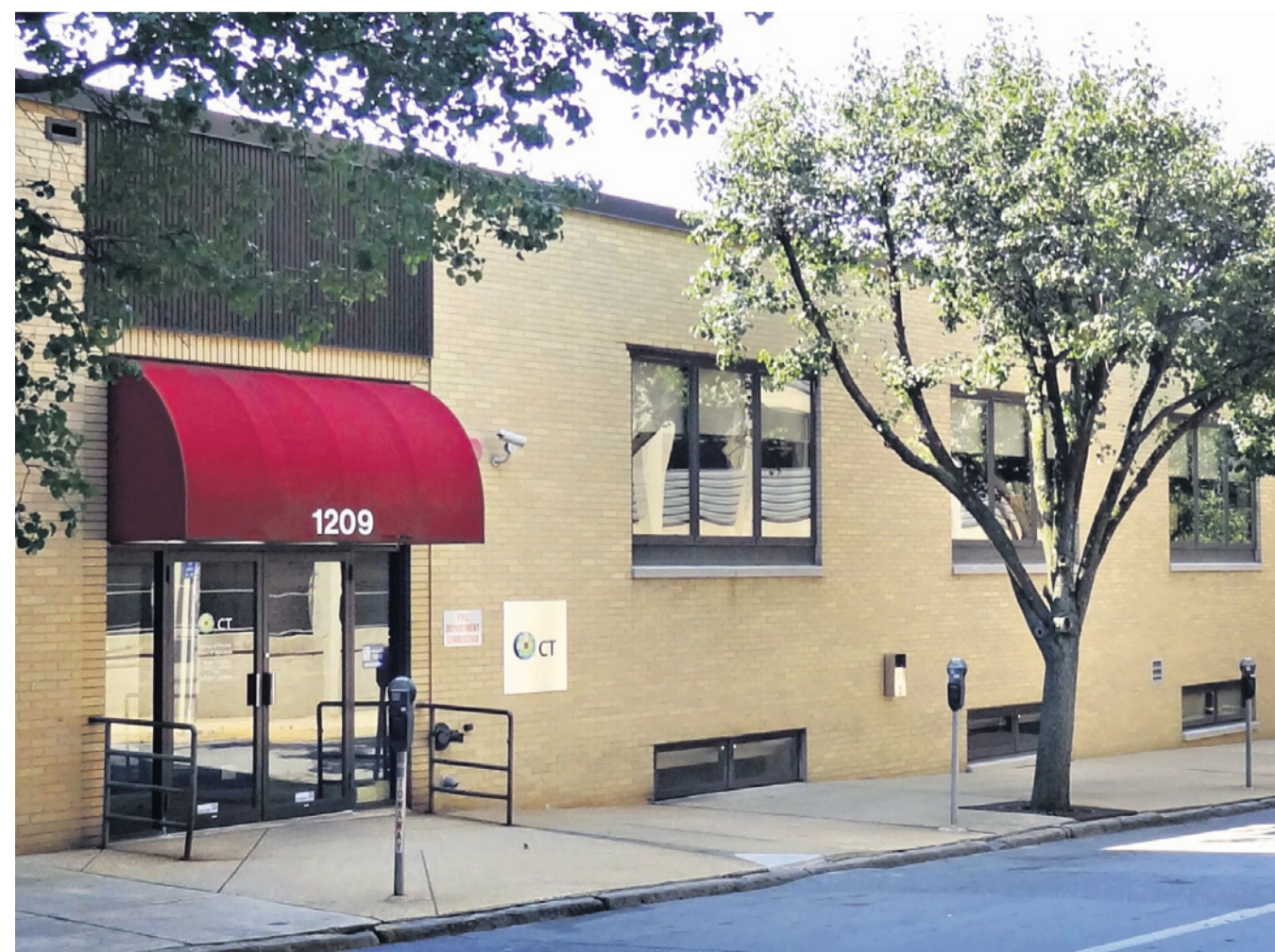
In diesem Haus im US-Bundesstaat Delaware haben 285.000 Firmen ihren Sitz.
