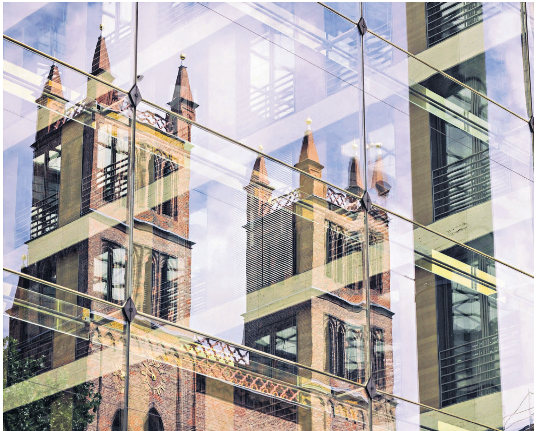
Die Friedrichswerdersche Kirche in Berlin wurde in den vergangenen Jahren völlig zugebaut und durch Baufehler in der Substanz beschädigt.
