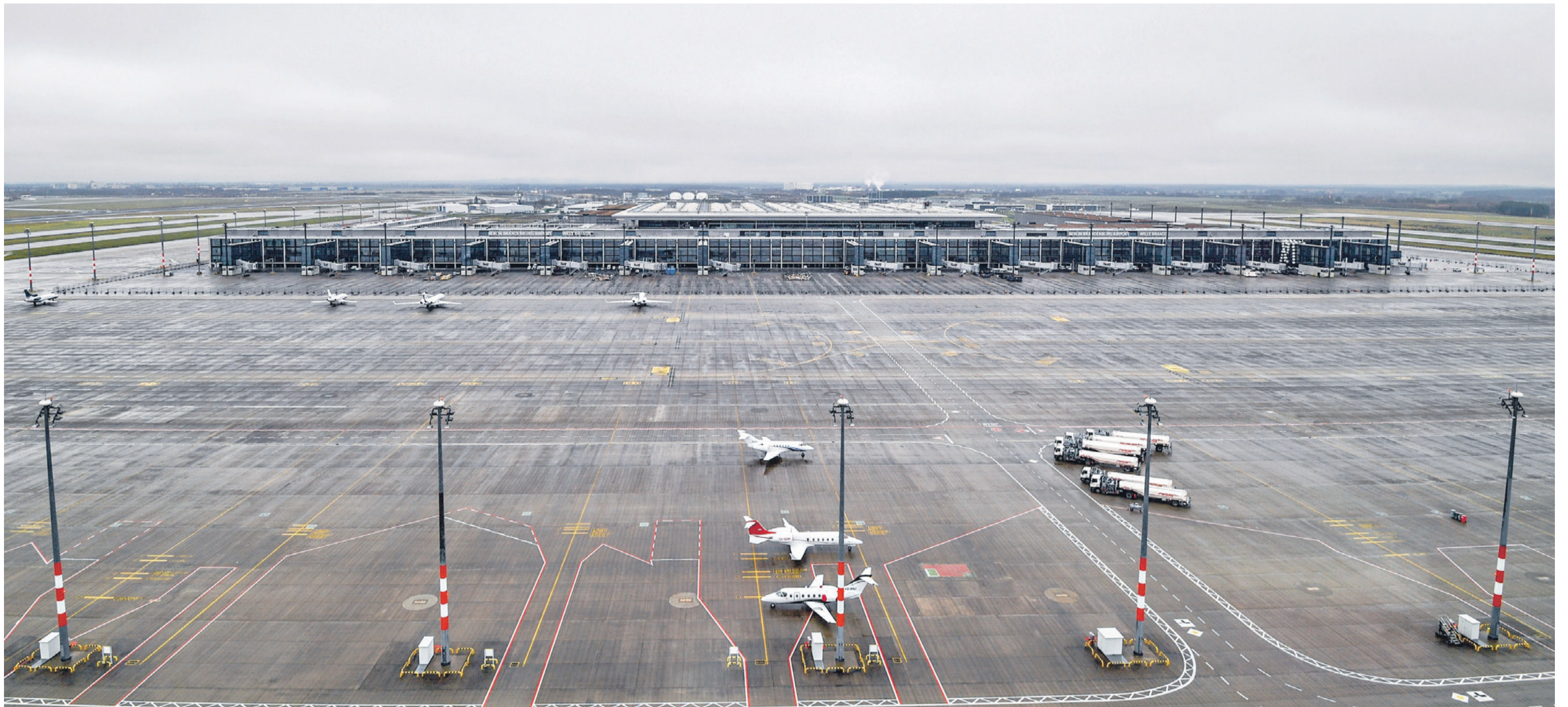
Von der größten Flughafenbaustelle Europas zum Milliardengrab: Der erste Spatenstich für den neuen Hauptstadtflughafen BER erfolgte am 5. September 2006, sechs Jahre später sollte das erste Flugzeug abheben. Doch wegen diverser technischer Mängel ist heute nicht einmal der neue Eröffnungstermin im Herbst 2020 gewiss.
