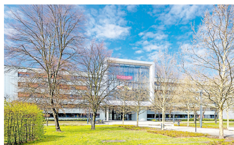
Wachstumstreiber: Hauptgebäude der Hochschule BTU in Cottbus
