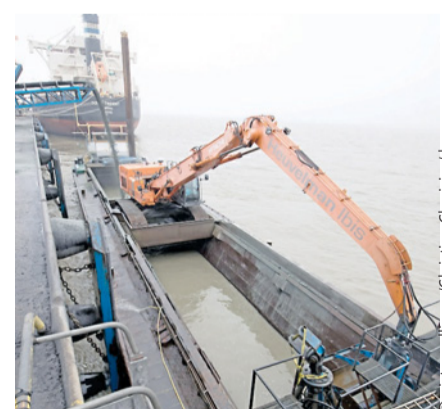
Die Elbvertiefung, hier ein Baggerschiff im Einsatz bei Brunsbüttel, ist umstritten.
