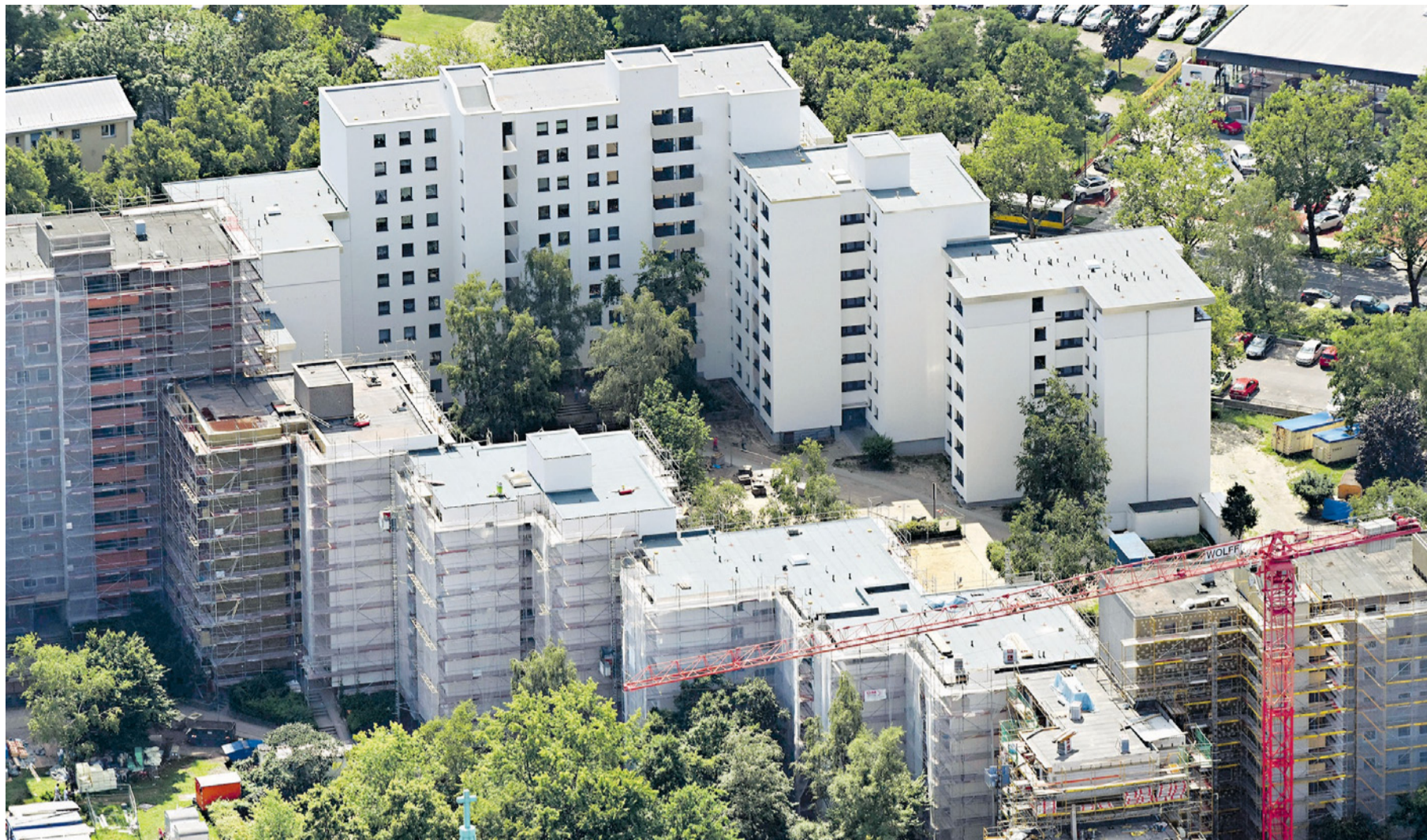
Bei der Sanierung einer kommunalen Wohnsiedlung in Berlin-Mariendorf soll durch Dämmung, moderne Technik und deren Steuerung die Energieeffizienz des Quartiers deutlich verbessert werden.
