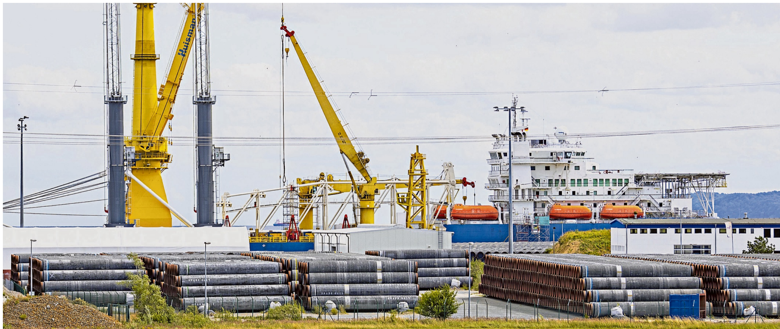
Nachdem US-Sanktionen im Dezember 2019 zum Rückzug beteiligter Firmen und einem Baustopp führten, wird das russische Pipeline-Verlegeschiff „Akademik Cherskiy“ für den Weiterbau der Gasleitung Nord Stream 2 im Fährhafen Mukran auf Rügen vorbereitet. Russlands Präsident Putin hofft, dass die Arbeiten spätestens im ersten Vierteljahr 2021 beendet sein werden. © picture-alliance/Jens Koehler
