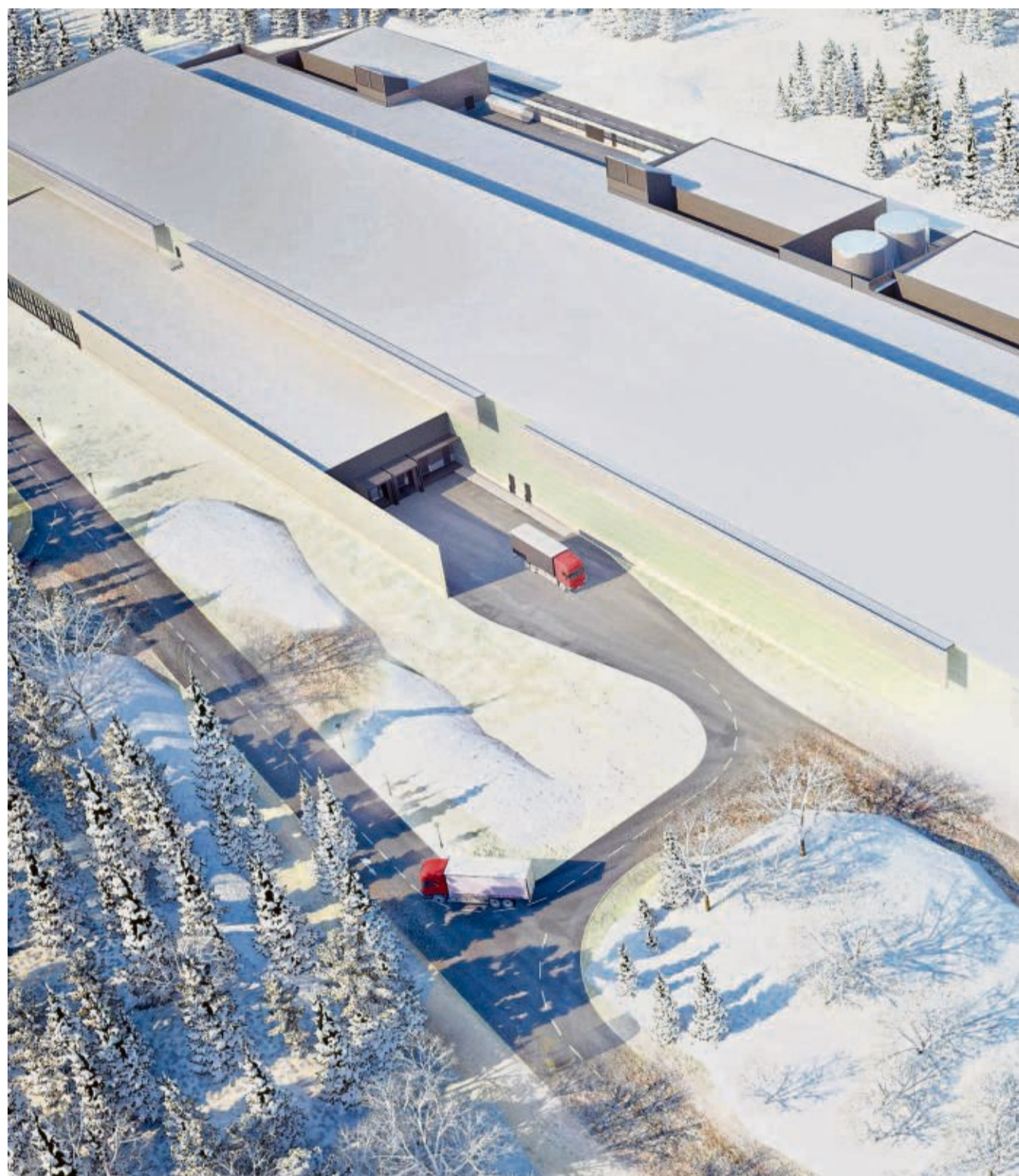
Daten für die Digitalgesellschaft: Das Facebook-Rechenzentrum in Luleå, Nordschwedens
