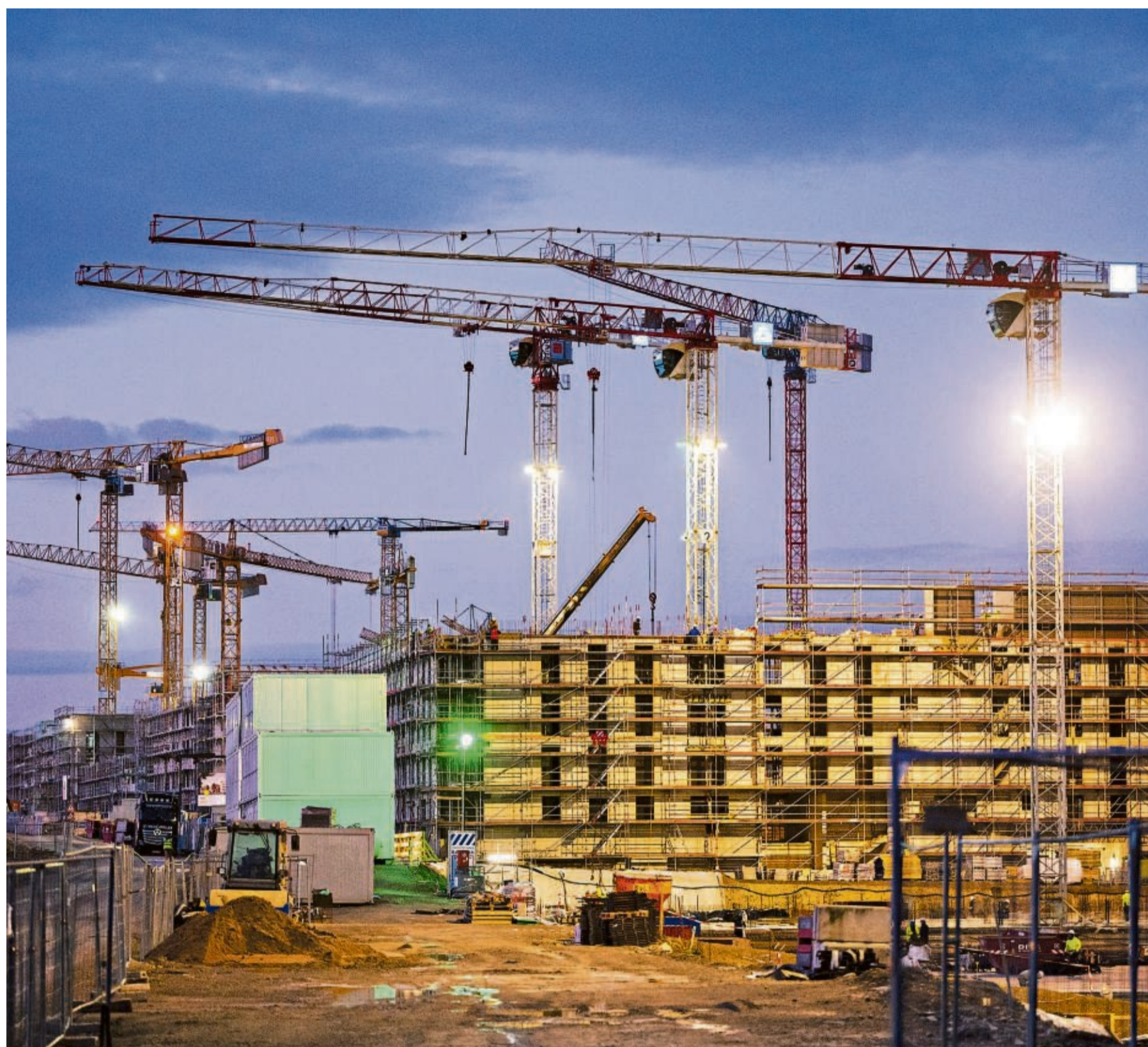
Mit großen Kränen gegen die hohe Nachfrage: 3.500 teils öffentlich geförderte Wohnungen sollen im Süden Hannovers entstehen.
