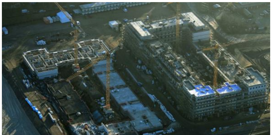
Bau einer Wohnanlage in Berlin
