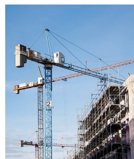
Bau eines Mehrfamilienhauses
