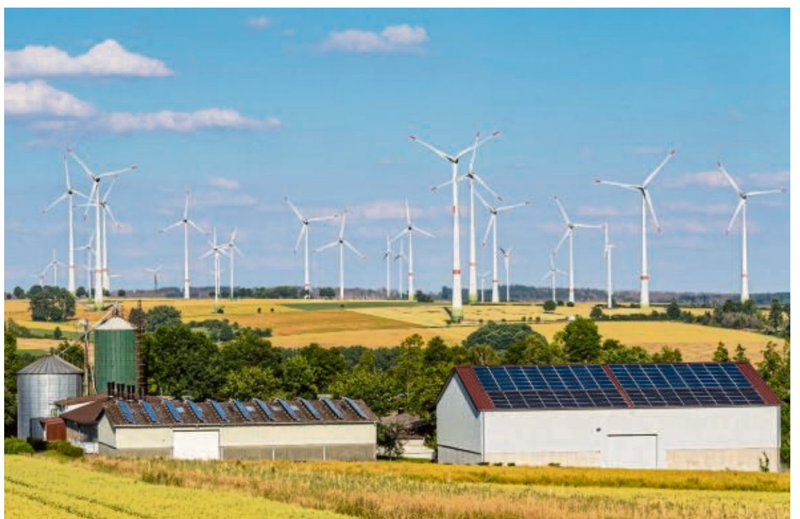
Ausbau erneuerbarer Energien: Windkraftanlagen wie hier im nordrhein-westfälischem Lichtenau-Assen sollen künftig auf zwei Prozent der Fläche des Landes stehen.
