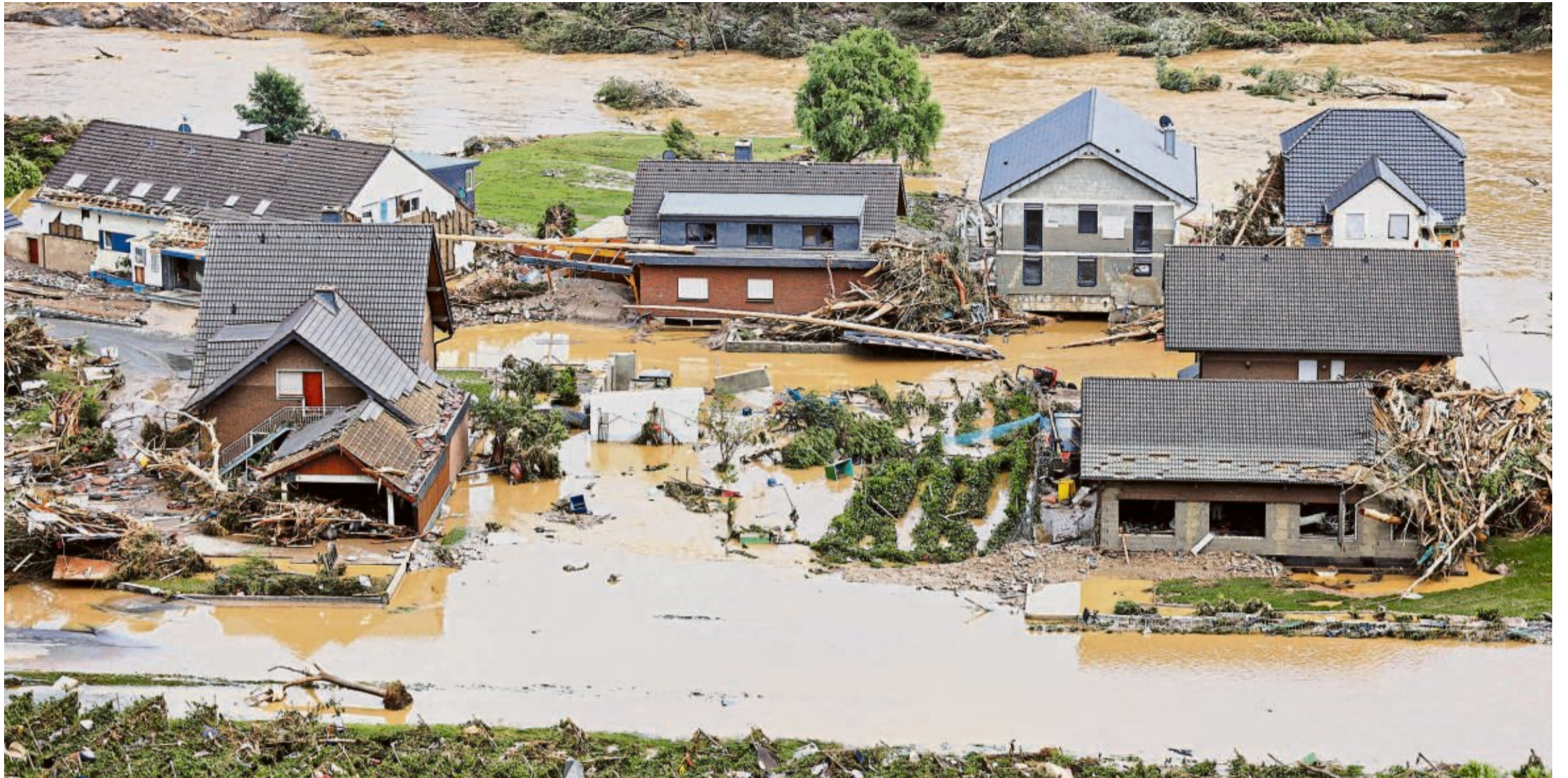
Blick in das verwüstete Ahrtal am 15. Juli 2021: Das Hochwasser führte in der Nacht zuvor zu verheerenden Schäden.
