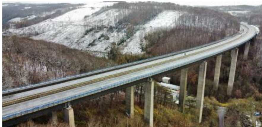
Die Ampel will marode Tunnel und Brücken schneller sanieren oder, wie hier die Talbrücke Rahmede bei Lüdenscheid, neu bauen. ©picture alliance/dpa | Kay-Helge Hercher
