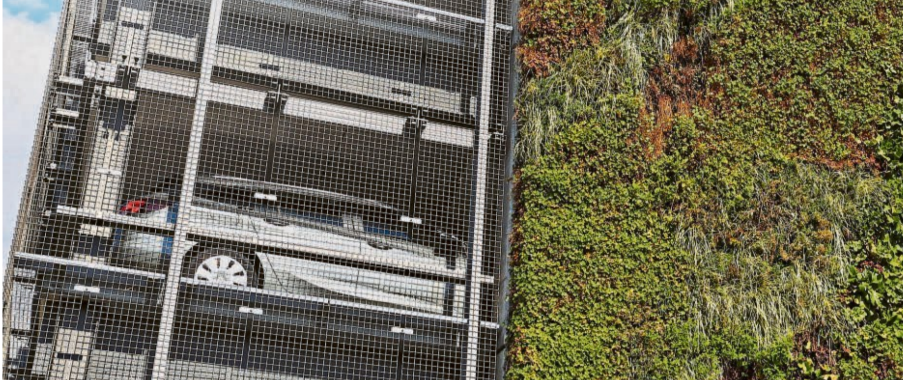
Ob auf dem Dach oder an der Fassade: Grün an Gebäuden, wie hier an einem Parkhaus in Bottrop, schützt Menschen vor Hitze und Lärm, bietet Insekten Raum und hilft, das Stadtklima zu verbessern. Doch Kommunen brauchen mehr, um sich gegen Klimafolgen zu rüsten.
