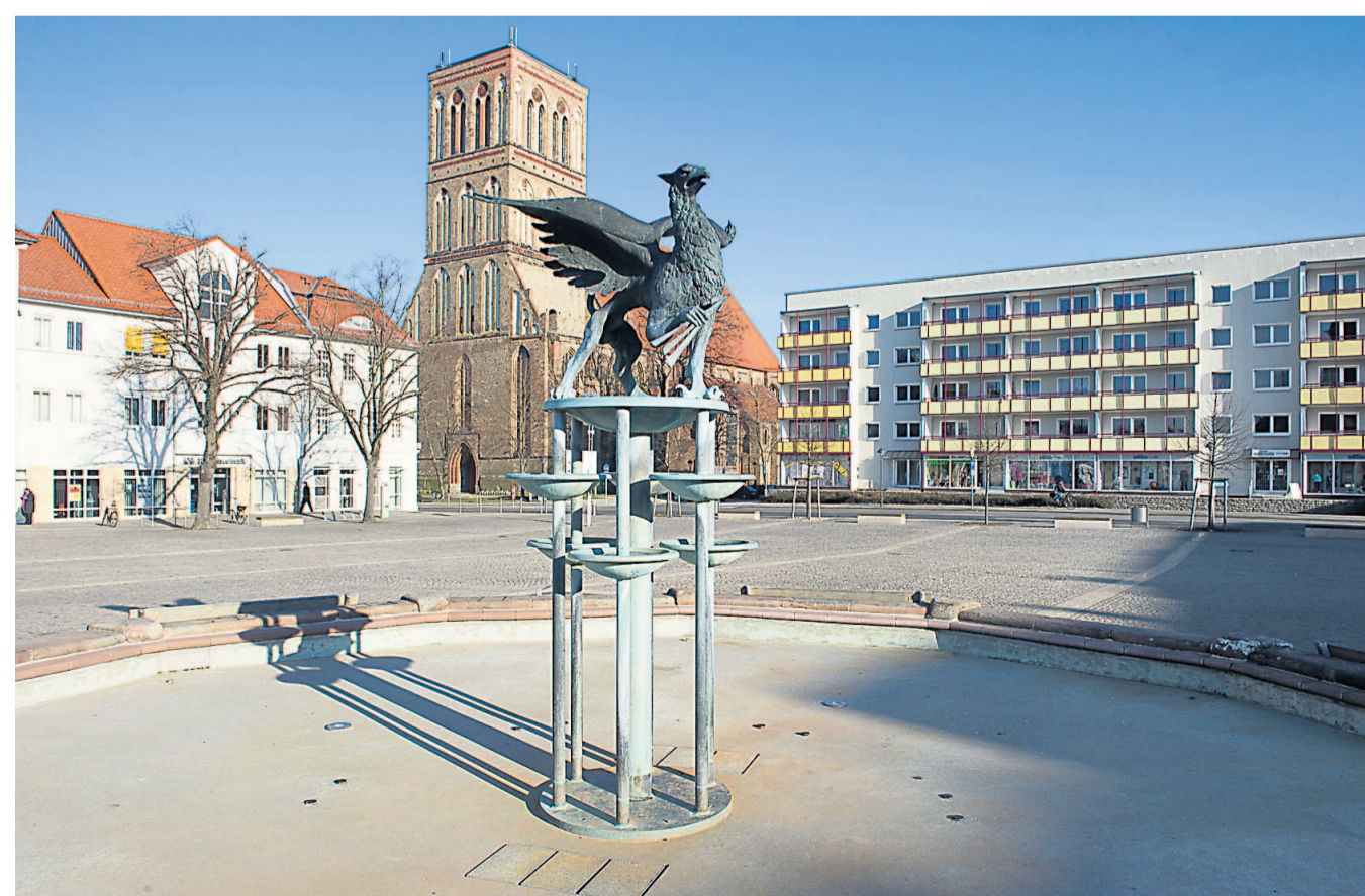
Mit dem demografischen Wandel kommen viele neue Aufgaben auf die Kommunen zu. Wegen des Rückganges der Bevölkerung sollen etwa in der Hansestadt Anklam Plattenbauten in der Innenstadt abgerissen werden.
