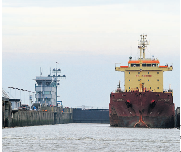
Wegen Schleusenarbeiten gesperrt: Nord-Ostseekanal
