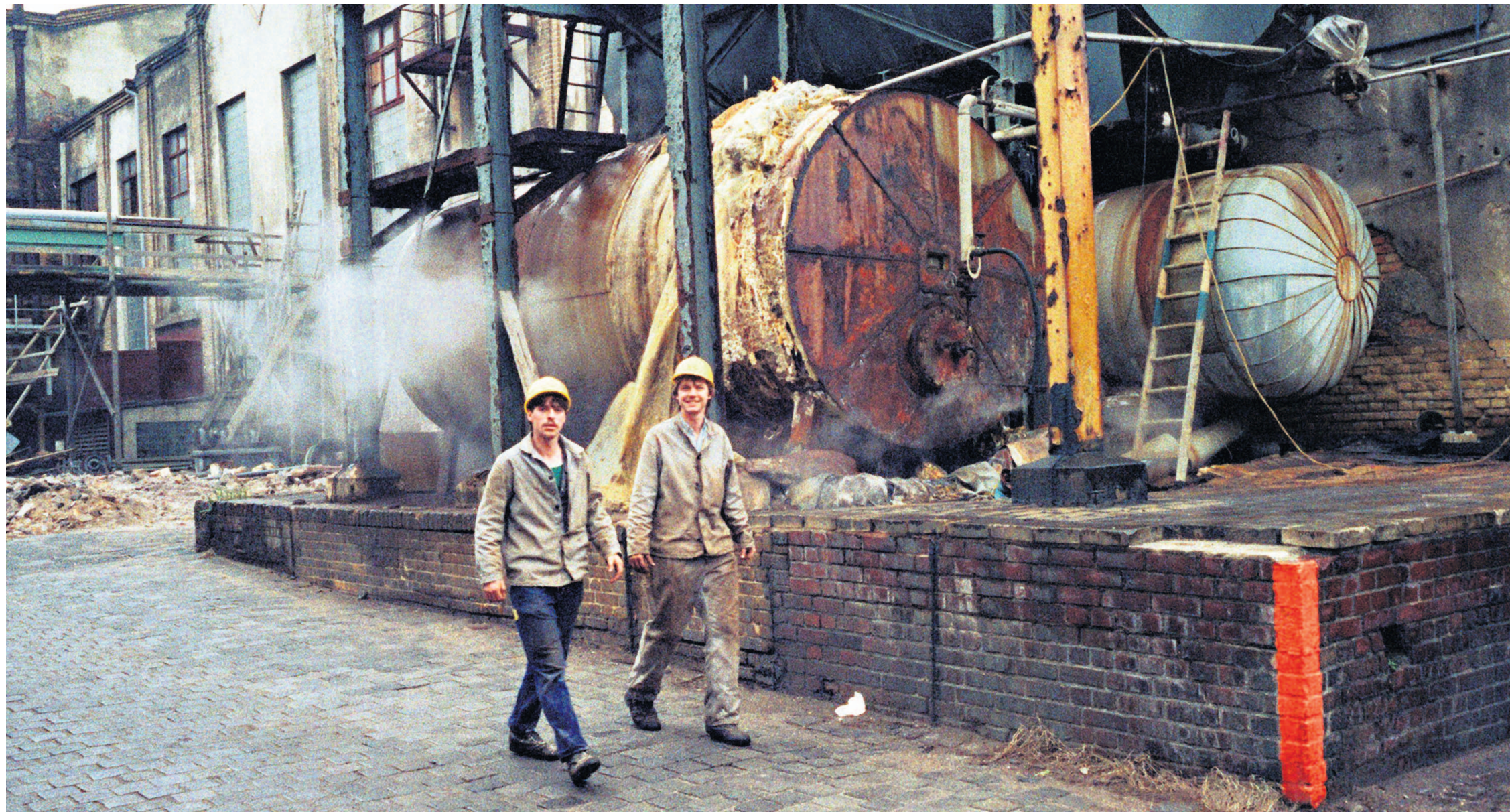
Industrieanlagen wie hier in einem Chemiewerk in Wolfen bei Bitterfeld waren oft völlig verrottet.
