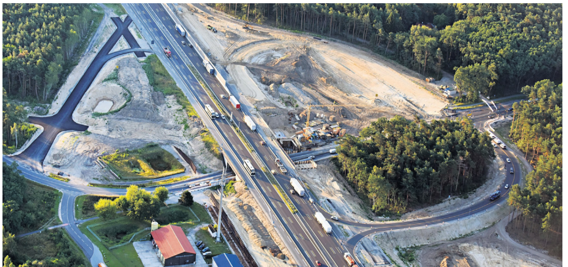
Autobahnbaustelle am Kreuz Michendorf bei Berlin: Vieles ist schon erreicht, aber noch längst ist die Einheit nicht vollendet.
