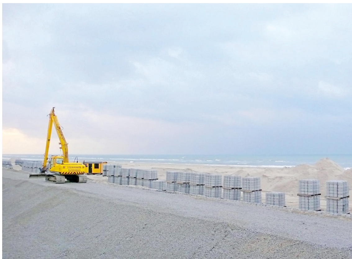
Die Nordseeküste rüstet sich für den Klimawandel: Neue Deiche sind nötig.
