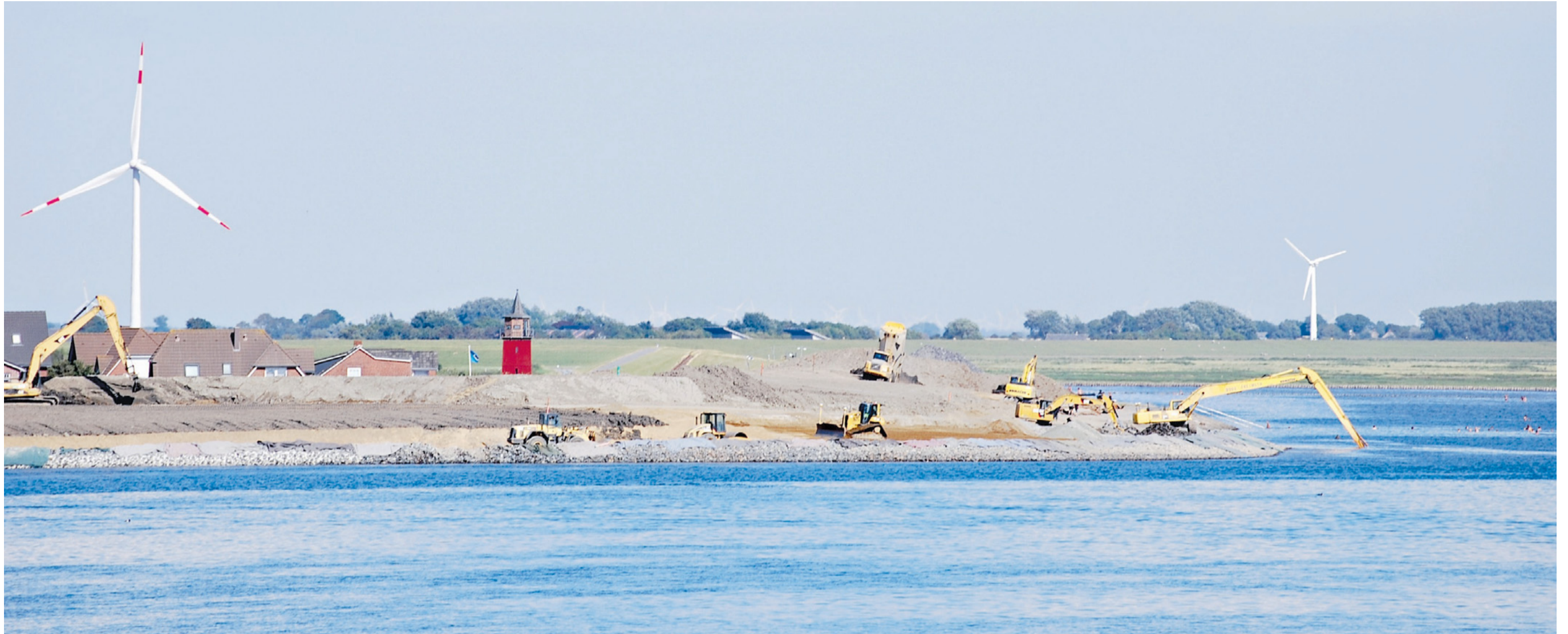
Noch liegt die Nordsee ruhig: Im schleswig-holsteinischen Dagebüll entsteht aktuell einer neuer Klimadeich. Mit einer Höhe von 7,95 Meter über Normalnull soll das Bauwerk die kleine Gemeinde vor den Gewalten des Meeres schützen.
