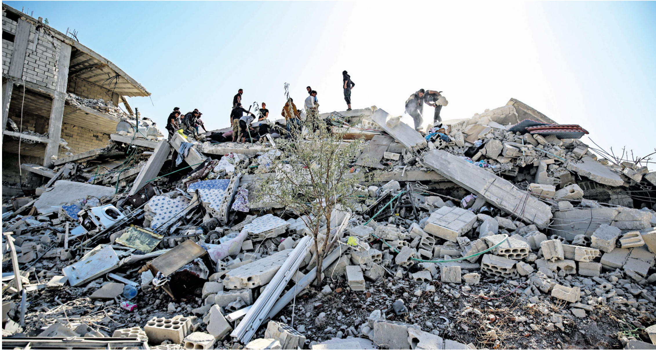
Nach einem Luftschlag eingestürzte Wohnhäuser im syrischen Idlib: Ohne Hilfe des Westens kann das vielerorts völlig zerstörte Land nicht aufgebaut werden.
