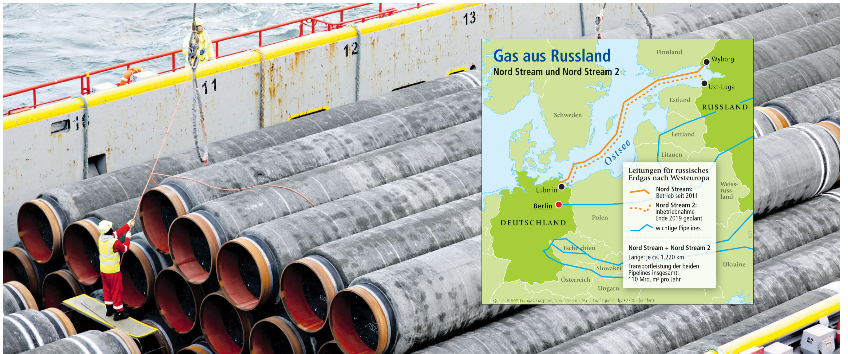
Viel Lärm um ein paar Rohre – hier auf dem Verleges Schiff „Audacia“, wo sie in einem Fließbandverfahren verschweißt und anschließend auf dem Grund der Ostsee vor der Insel Rügen verlegt werden.
