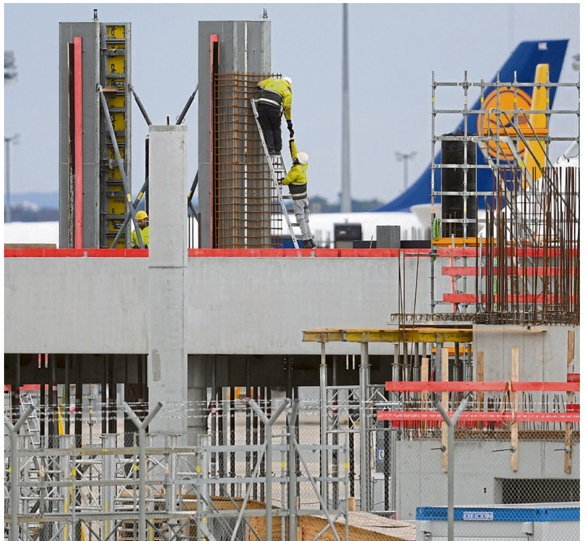
Planungsaufgaben für Bauprojekte wie etwa hier beim Bau des Terminals Drei am Frankfurter Flughafen liegen in der Zuständigkeit der Länder und Kommunen.
