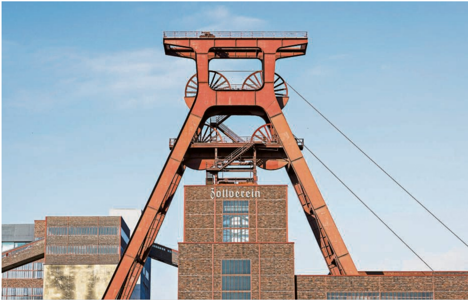
Wahrzeichen des Ruhrgebiets: Schon von weitem weist das rote Doppelbockfördergerüst Besuchern den Weg zur Zeche Zollverein. Wo früher bis zu 24.000 Tonnen Kohle am Tag gefördert wurde, befinden sich heute Museen, Start-Ups und jede Menge Kulturangebote.
