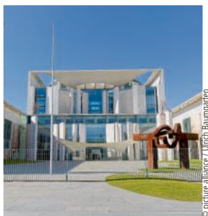
Nach vier Jahren Bauzeit wurde das Bundeskanzleramt 2001 eingeweiht.
