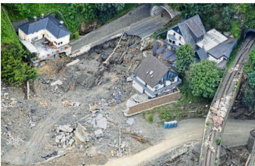
Zerstörte Gebäude, Straßen und Brücken im Ahrtal nach der Hochwasserkatastrophe im Juli 2021
