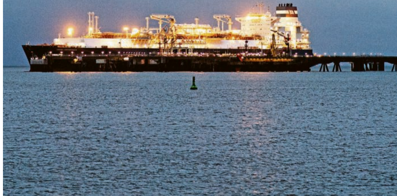
Die schwimmenden LNG-Terminals – wie hier bei Wilhelmshaven – sind in Rekordzeit errichtet worden. Bundesjustizminister Marco Buschmann (FDP) sieht das als neue „Richtgeschwindigkeit“ für bedeutsame Infrastrukturvorhaben im Land. © picture-alliance/Hauke-Christian Dittrich
