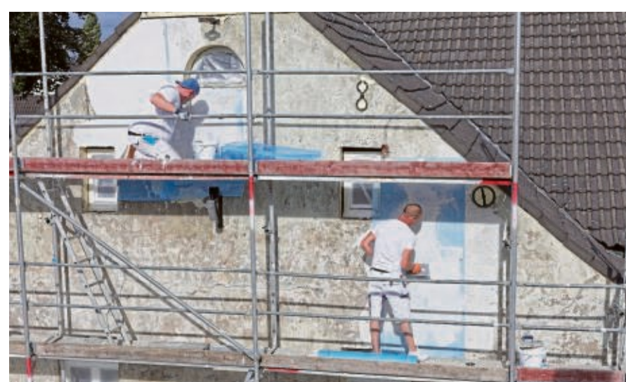
Umbauen und renovieren gilt als klimafreundlicher als neu zu bauen.
