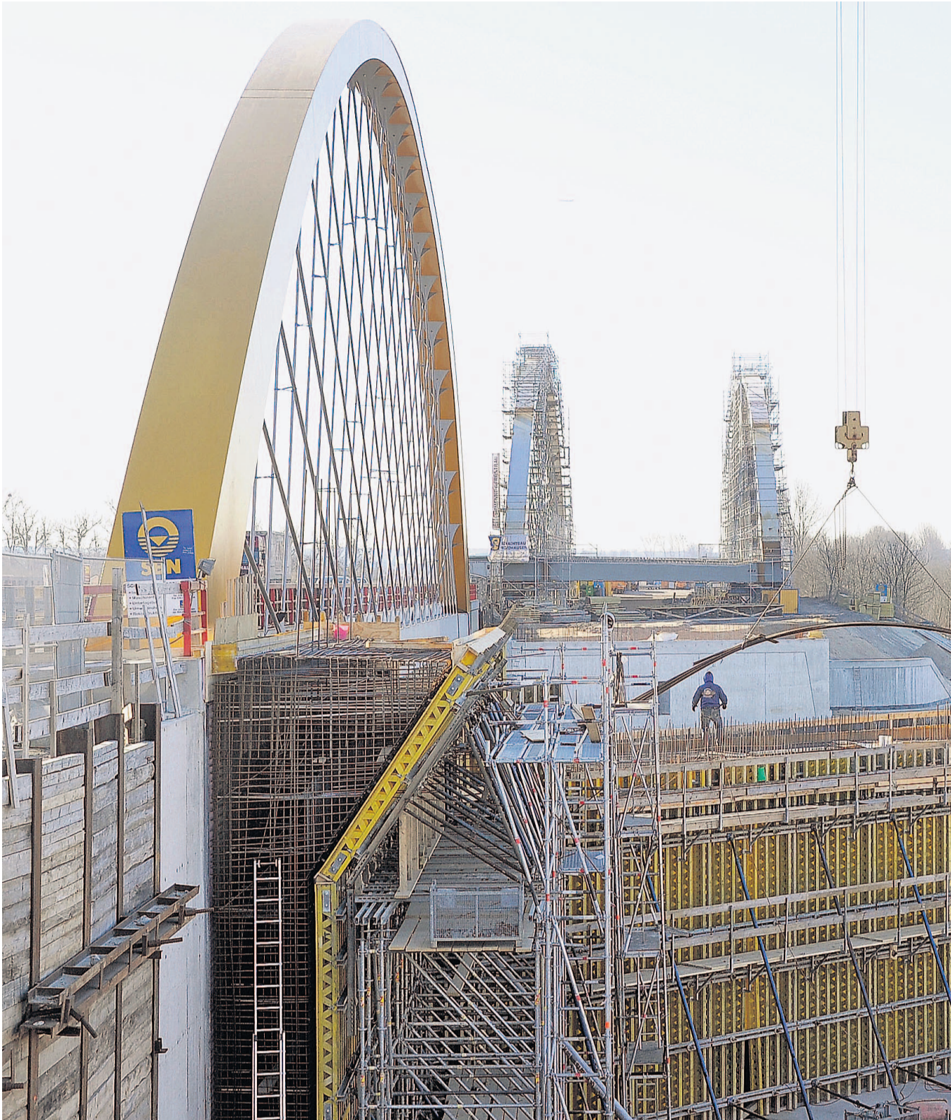
Bauarbeiten der Autobahnbrücke über den Havelkanal bei Brieselang
