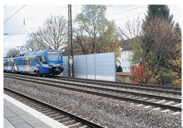
Schutzwände sollen die Bevölkerung vor Lärm schützen.
