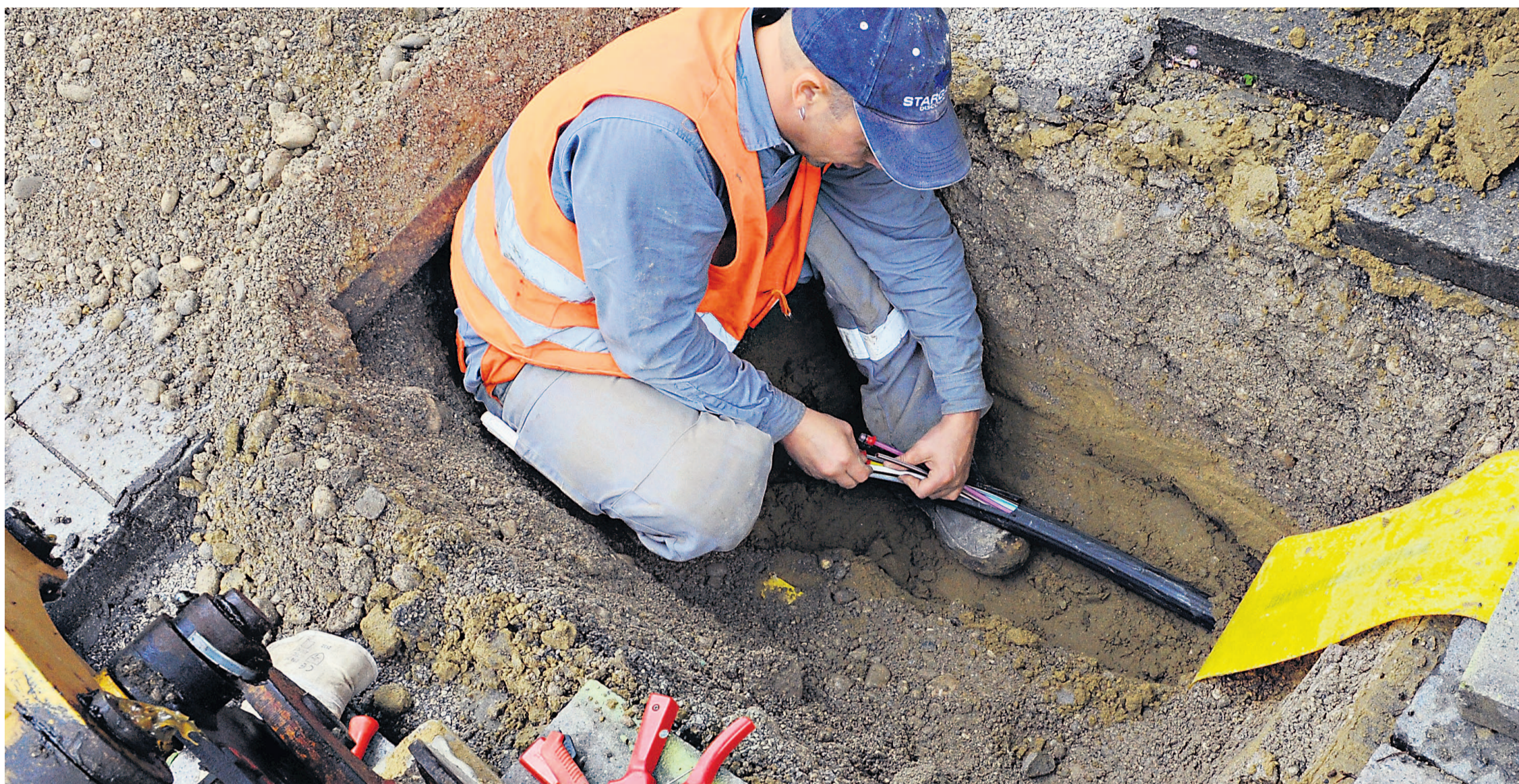
Beim Breitbandausbau entstehen die meisten Kosten bei den Tiefbauarbeiten.
