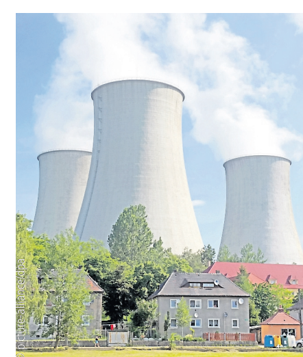
Braunkohlekraftwerk in Turów
