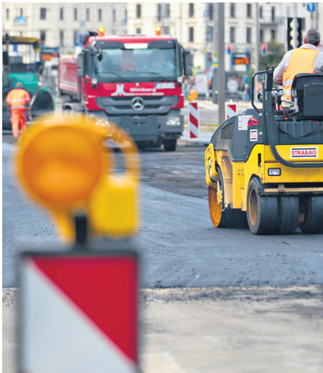
In Leipzig wird eine Asphaltdecke auf eine Straße aufgetragen. Die Mittel kommen auch aus dem Solidarpakt.
