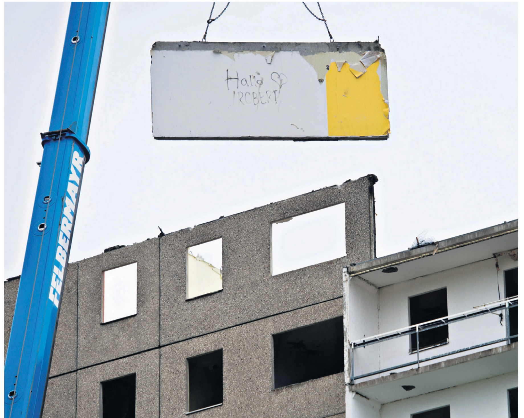
Rückbau einer Plattenbausiedlung in Frankfurt (Oder) im November 2013
