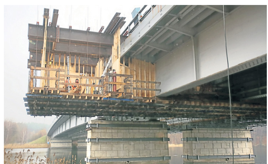
Mehr Geld wird auch für Brückensanierungen bereitgestellt.
