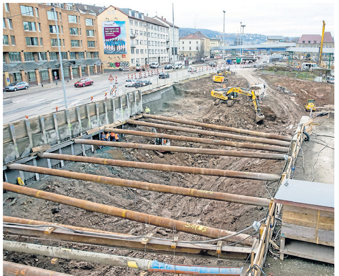
Wo gebaut wird, sollen zukünftig auch Glasfaserkabel verlegt werden.
