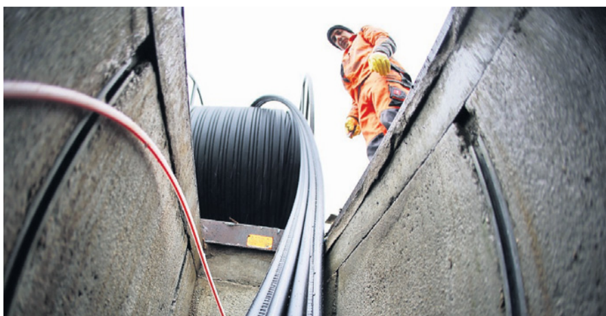
Die Verlegung von Glasfaserkabeln soll vorangetrieben werden.
