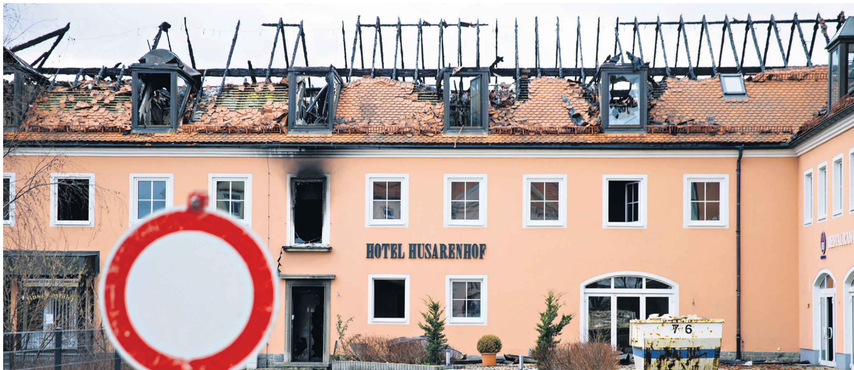
Das abgebrannte ehemalige Hotel „Husarenhof“ in Bautzen in Sachsen. Das Haus war als Flüchtlingsunterkunft vorgesehen und fiel einem Feuer zum Opfer. Die Polizei geht von Brandstiftung aus.
