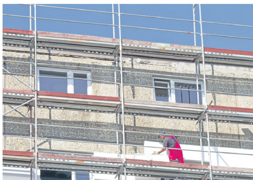
Handwerker bei der Dämmung der Außenfassade eines Plattenbaus
