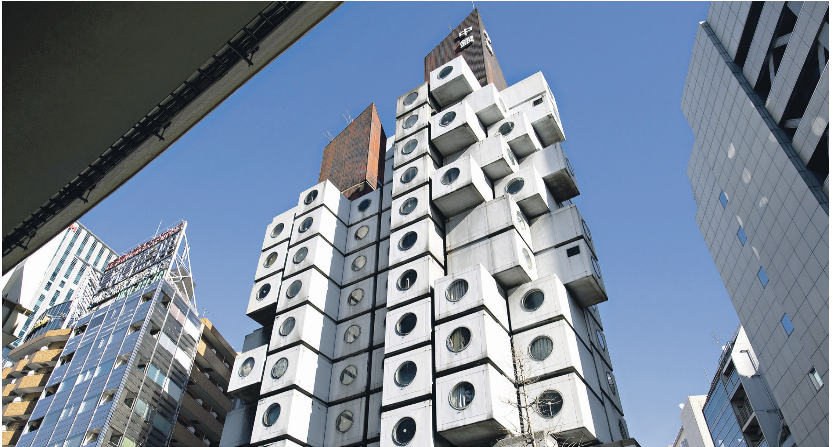
In die Jahre gekommen, aber immer noch eine Ikone modularen Bauens: Der Architekt Kisho Kurokawa setzte 1972 beim „Nakagin Capsule Tower“ in Tokio auf typgleiche Wohnmodule, die flexibel miteinander zu verbinden sind. Auf diese Art lassen sich – zumindest der Idee nach – Bauten den wandelnden Bedürfnissen ihrer Nutzer und Bewohner anpassen.
