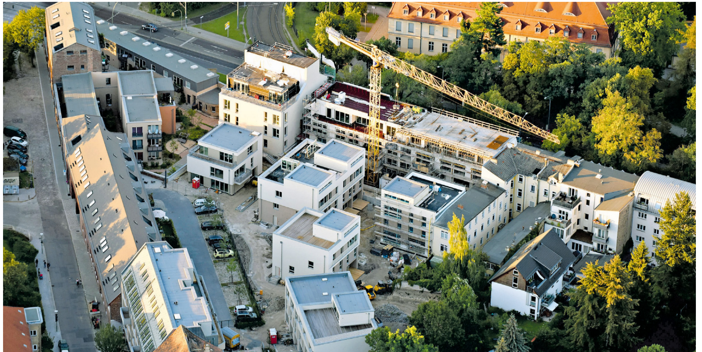
Dicht und sicher nicht billig: Baustelle zum Neubau einer Mehrfamilienhaus-Anlage an der Heinrich-Mann-Allee in der Potsdamer Innenstadt
