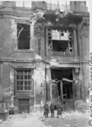
Zerstörtes Portal des Schlosses
