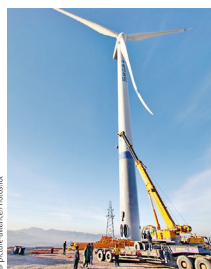
Aufbau einer Windkraftanlage in China
