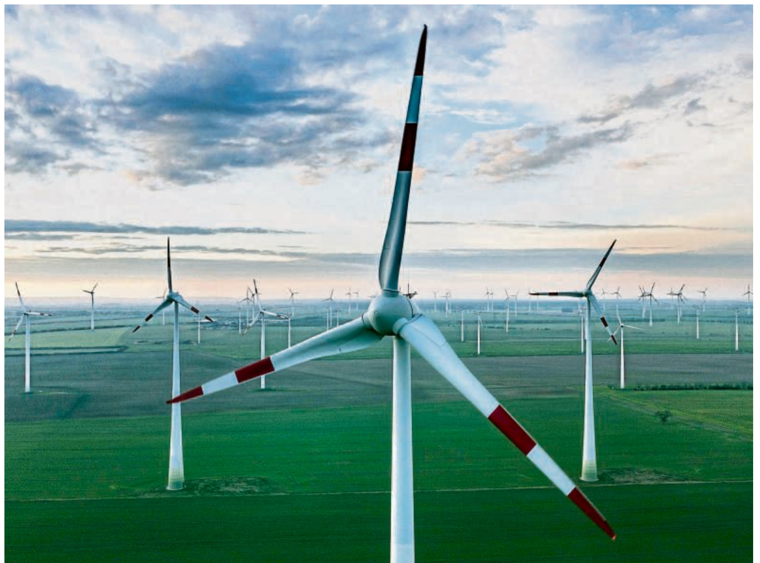
Weltweit werden neue Windparks gebaut und erweitert, um den steigenden Bedarf an erneuerbaren Energien zu decken.
